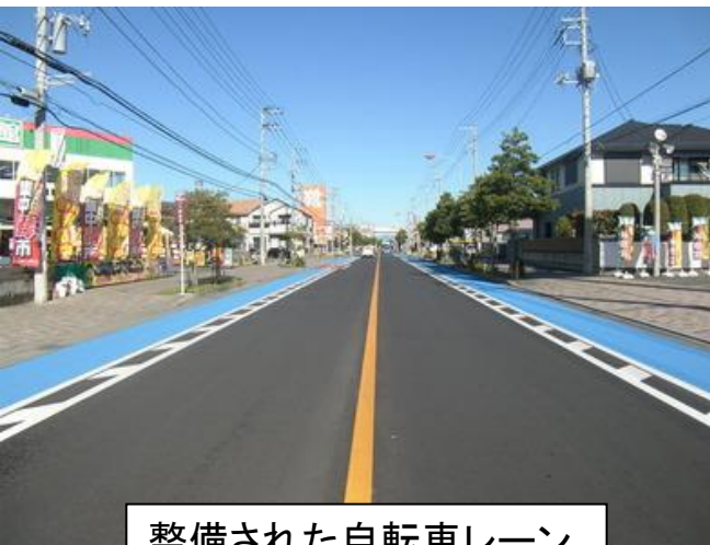
整備された自転車レーン
